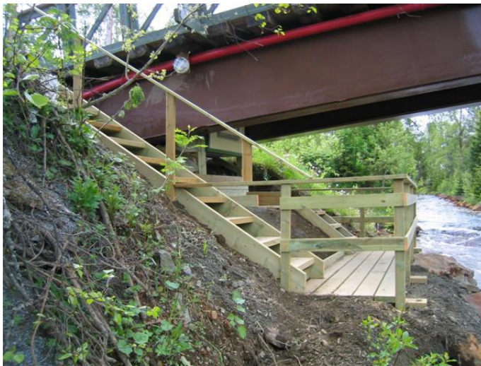
Een meetstation onder een brug
